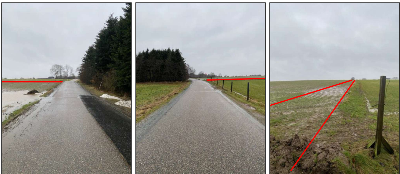
Figur 3.6 Oversigtsforhold i det fremtidige T-kryds Mausingvej/Viborgvej, set fra hhv. den nordlige og sydlige tilfart., samt den kommende østlige tilfart, set fra krydset. Den østlige tilfart er på alle 3 billeder vist med rødt.
