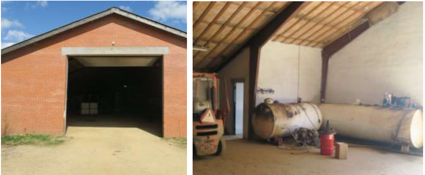
Figur 4.16: Maskinhal udvendig (tv.) og indvendig med to tanke (th.).
