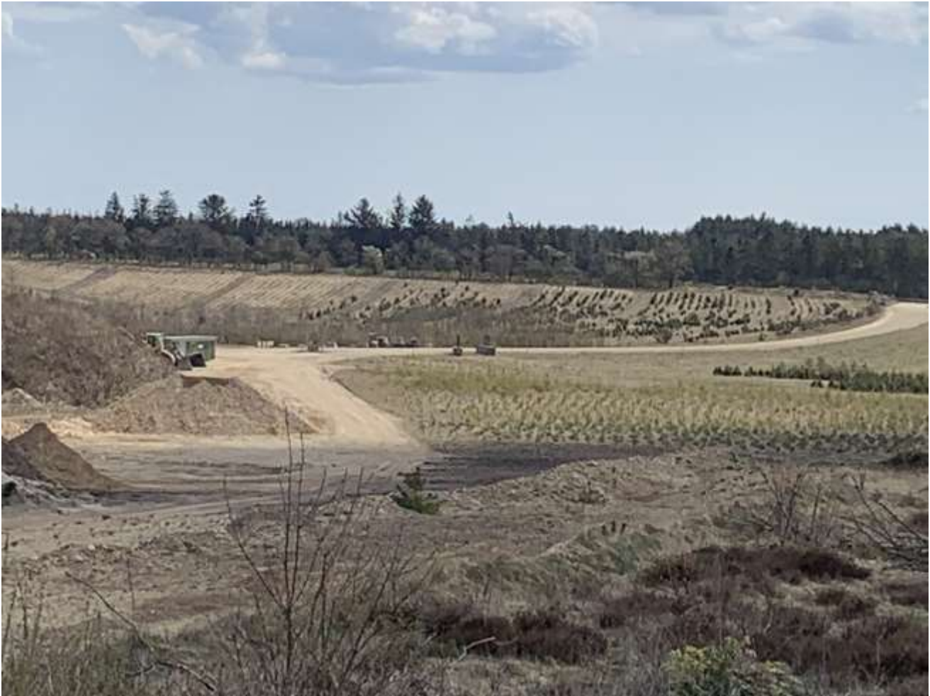
Figur 4.18: Udsigt mod sydøst mod adgangsvejen og Skyggevej. Mellem grusvejen og Skyggevej er terrænet efterbehandlet med hældning omtrent 1:10 og tilplantet med skov.
