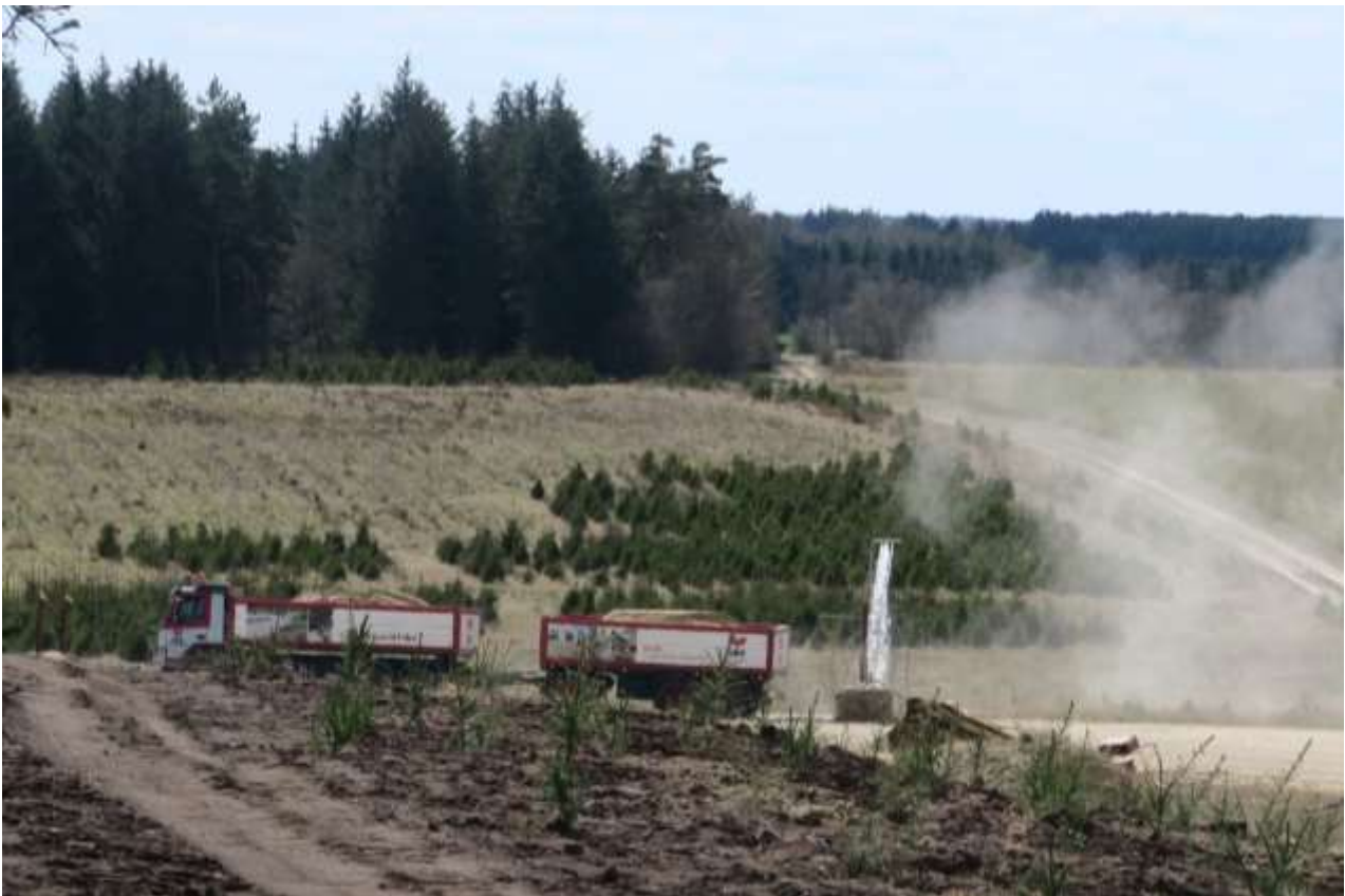
Figur 10.1: Vandingsanlæg til lastbillæs. Vandsøjlen ses lige til højre for lastbilerne.
