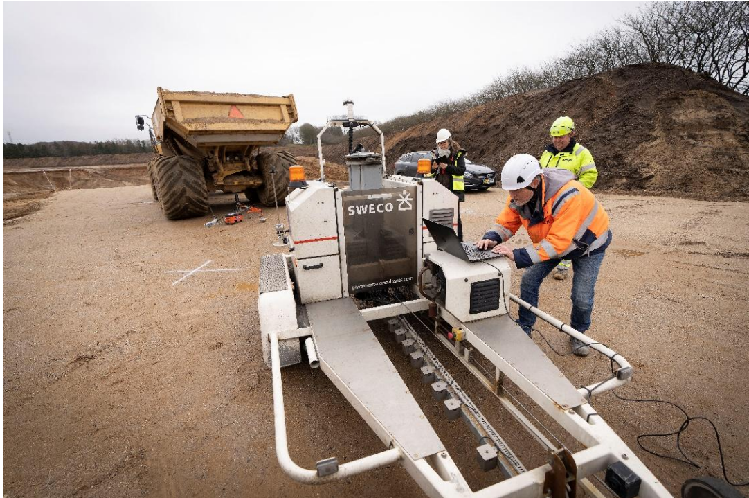
Figur 9. Der gøres klar til målinger med stort faldlod på lokaliteten på overfladen af SG II. Dumperen står på overfalden med Nyt Stabilt Grus.
