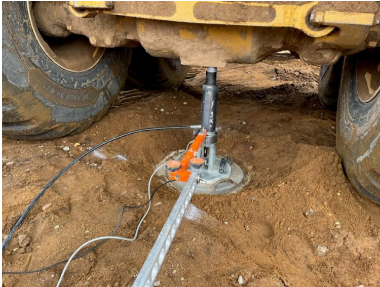
Figur 5. Den første statiske pladebelastningsmåling på råjordsplanum.
