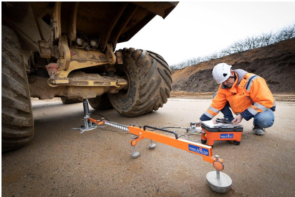
Figur 8. Der måles med statisk pladebelastningsudstyr på overfladen af det indbyggede SG II lag.
