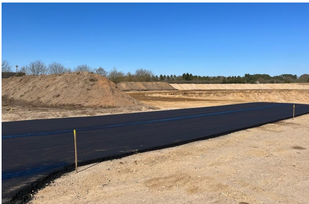
Figur 11. Der er den 17. april 2023 blevet lagt asfalt (130 mm GAB 0 type 16) på prøvestrækningen ind i råstofgraven.
