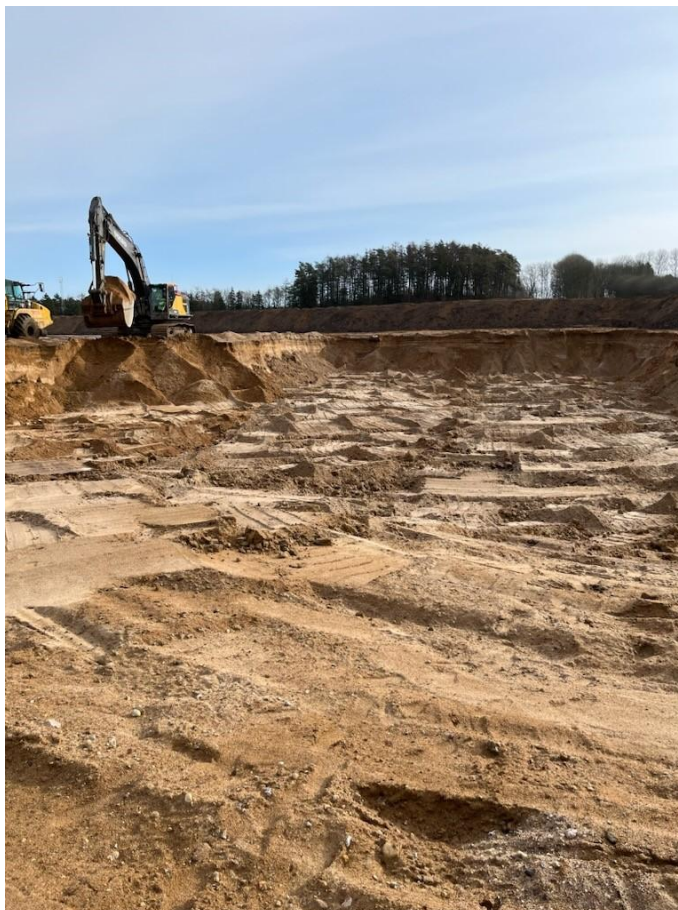
Figur 4. Råjordsplanum, hvor prøvestrækningen bliver etableret.
