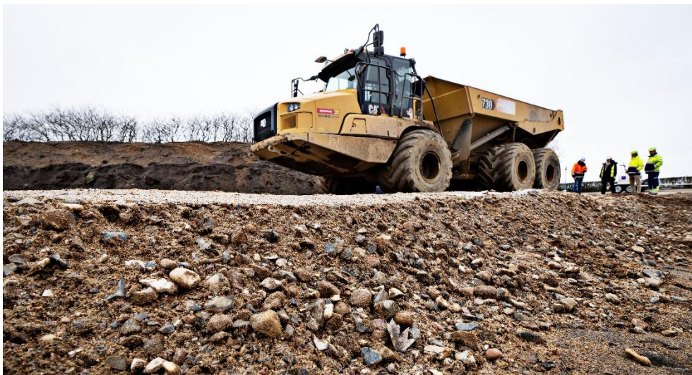
Figur 6. Indbygningen af 20 cm stabilt grus på prøvestrækningen (de stenede materialer ses i forgrunden af fotoet ovenpå råjorden, der anes svagt til højre i fotoet). Overfladen af prøvestrækningen synes lys under dumperen, hvilket skyldes våde forhold efter to dages regn.
