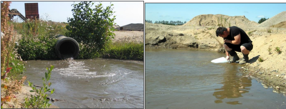
Figur 2-25: Foto til venstre: Udløb af vaskevand. "Udløbsvand 1". Foto til højre: "Udløbsvand 2" (dykket udløb). Udløbet fra dette sorteringsanlæg er umiddelbart under vandspejlet.
