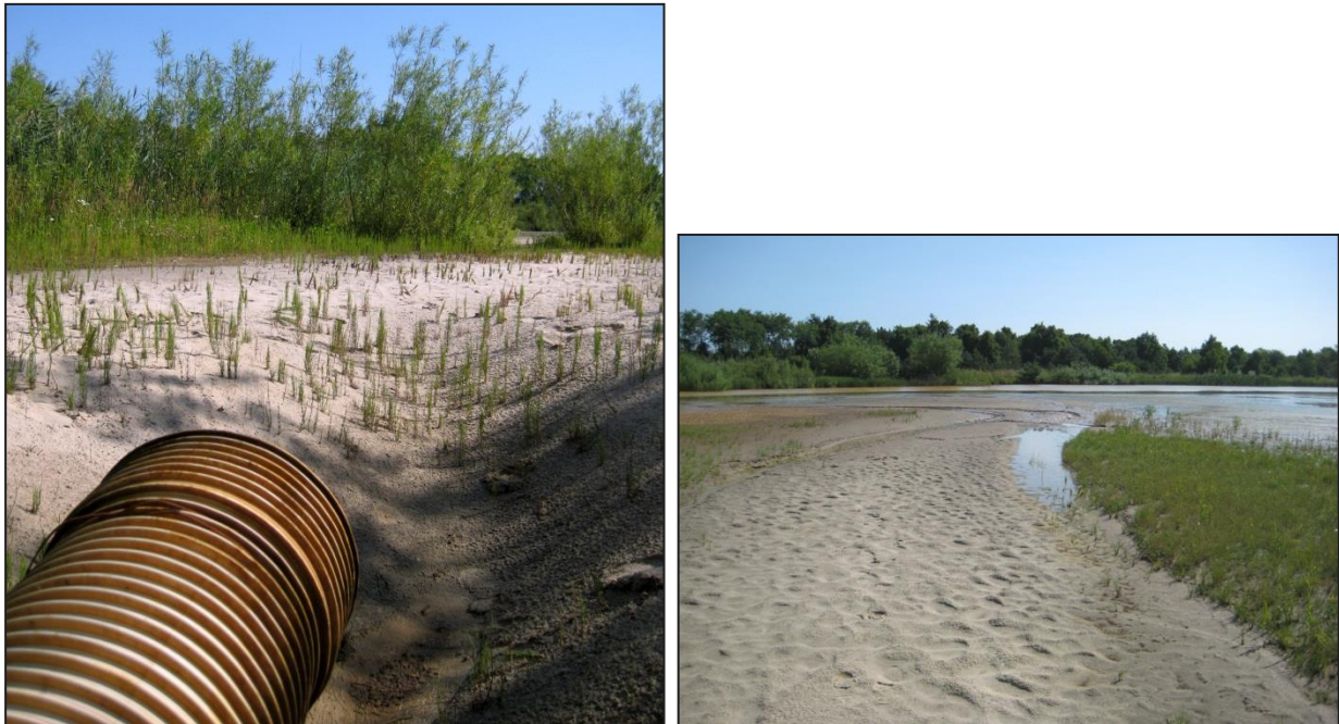
Figur 2-10: Udløb af vaskevand til sedimentationsbassin. Udløbet var tørt på prøvetagningstidspunktet.
