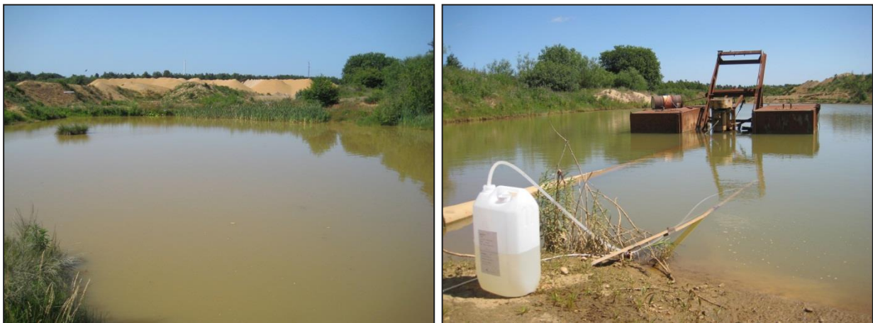
Figur 2-11: Foto til venstre: Det nordlige sedimentationsbassin "sedimentationsbassin 1" jævnfør situationsplanen Figur 2-8. Foto til højre: Det sydligste sedimentationsbassin ved vaskesøen "sedimentationsbassin 2" jævnfør situationsplanen Figur 2-8. Anlægget i søen anvendes til indpumpning af grusvaskevand..
