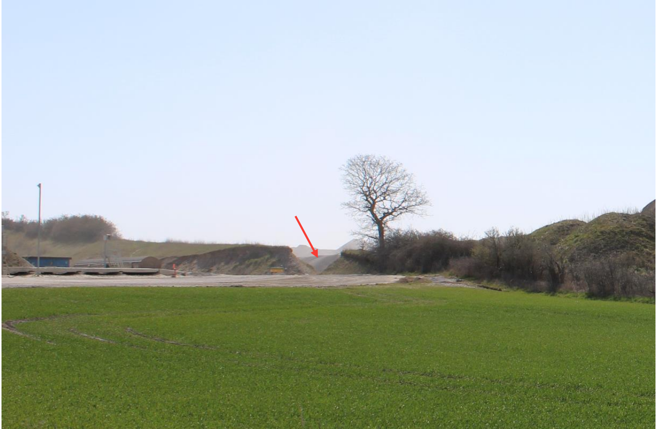
Figur 4-3 Adgang til Tirstrup og Ørup Grusgrave, adskilt af et dige, der er gennembrudt til kørsel mellem de to grave. Gennembruddet af diget er vist med rød pil. Foto taget den 20. april 2021.
