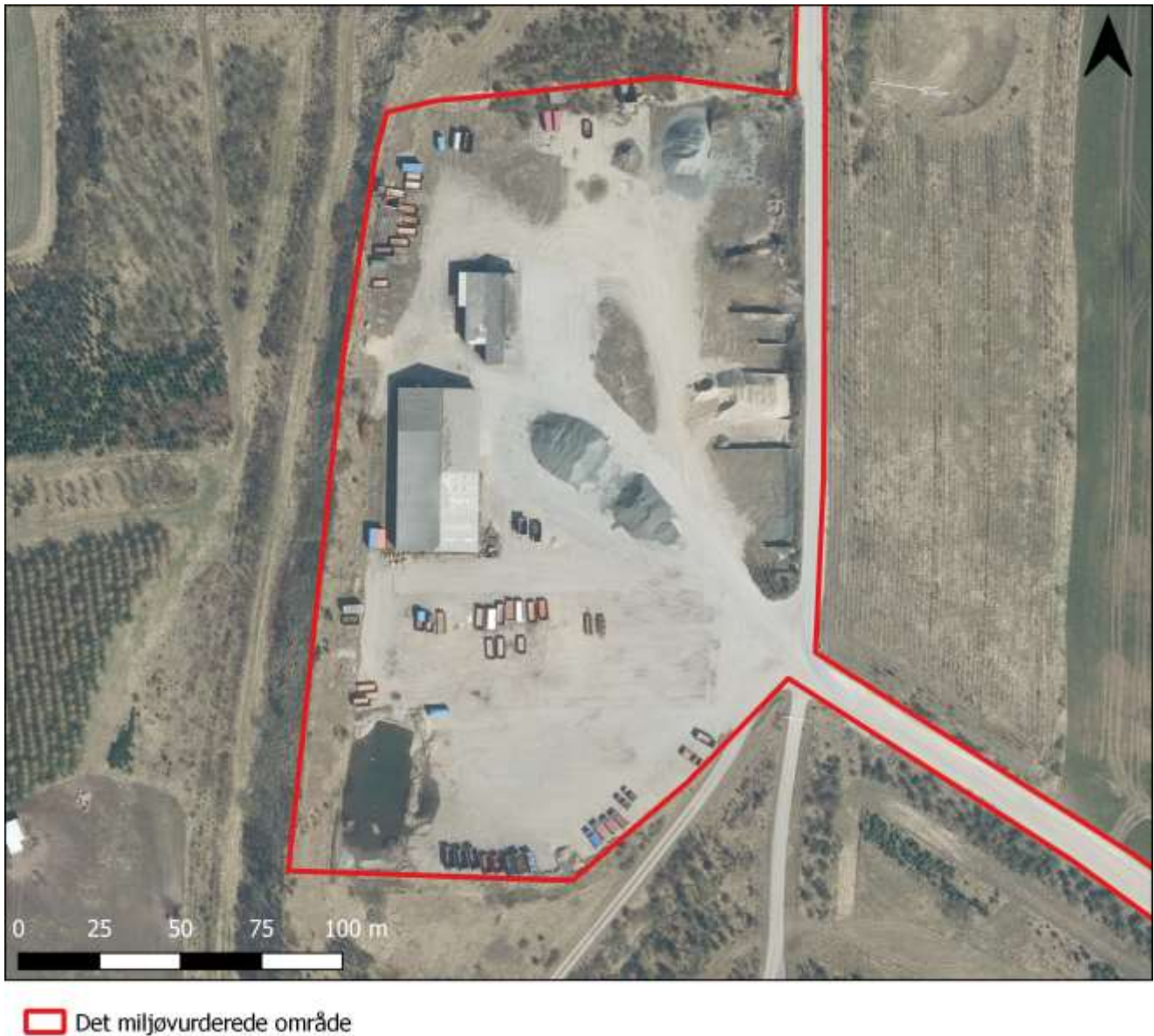
Figur 4.10: Lille bygning: Maskinhal/mandskabsbygning. Store bygning: lagerhal. DDO 2021.
