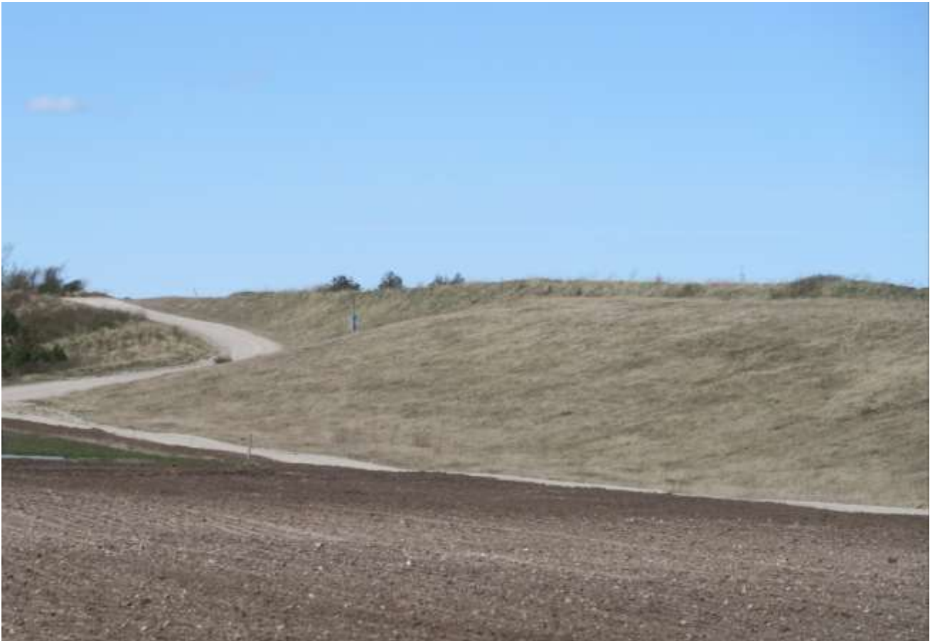
Figur 7.7: Efterbehandlet areal ved nordøstenden af den nuværende råstofgrav, set mod nord. Set fra råstofgraven, mod adgangsvejen (se Figur 7.2). Foto; NIRAS, 27. april 2021.
