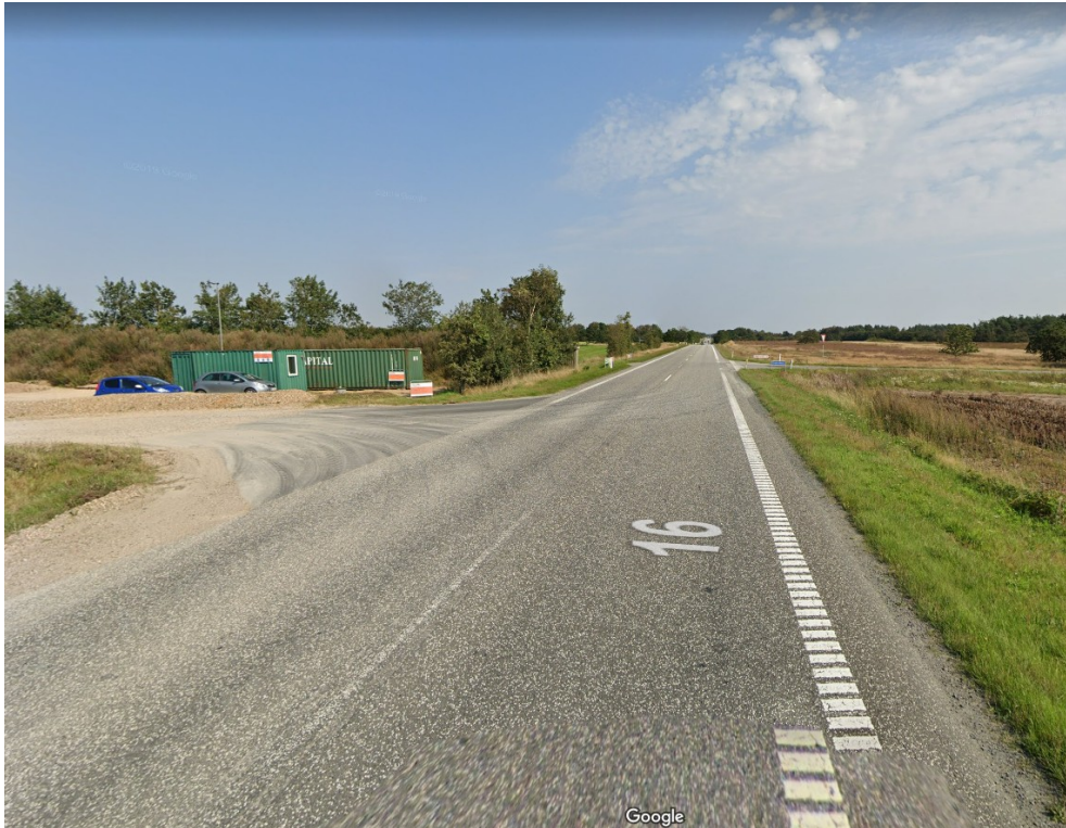
Figur 14: Overkørsel ved eksisterende grusgrav og udkørsel fra Grønnevang. Set mod øst. Google Street View.
