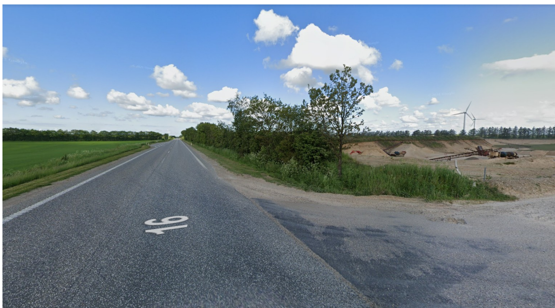
Figur 5: Udkørsel fra Skave Grusgrav set mod vest
