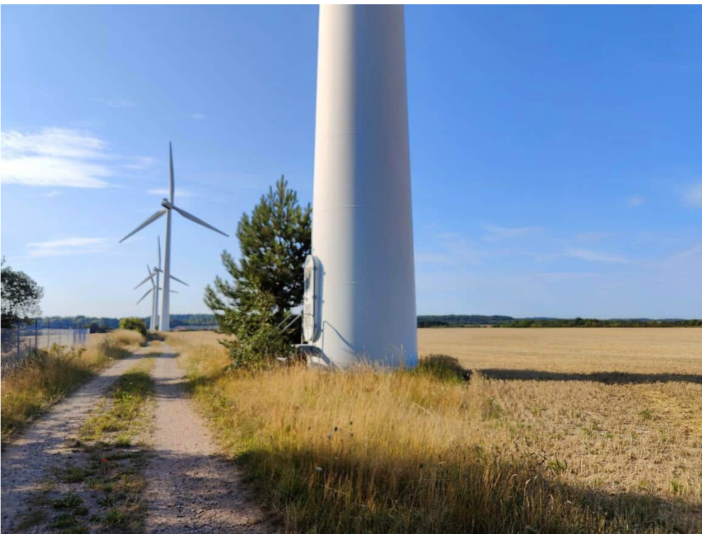
Adgangsvej til vindmøller med dige til venstre. 29-05-2022 (øverst) og 14-08-2022 (nederst)
