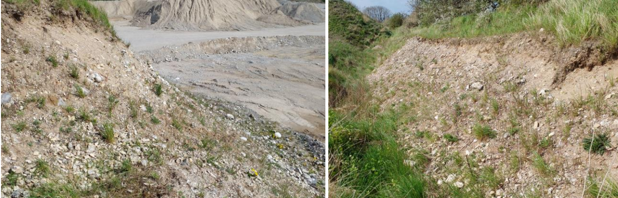
Billede 3. Billeder af den sydøst-vendte skråning med stor tilgroning og løse sten.
