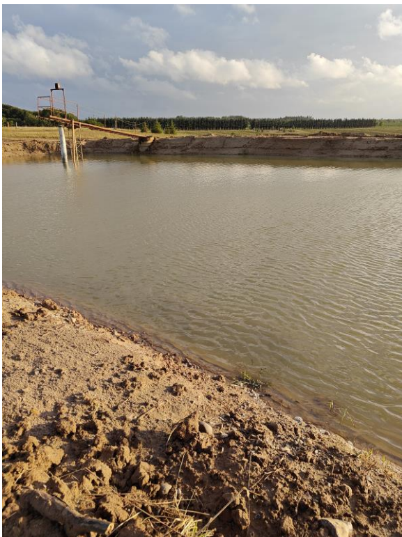
Figur 13: Ved anden besigtigelse var området for nyligt opgravet. FOTO: NIRAS 4. juli 2023.
