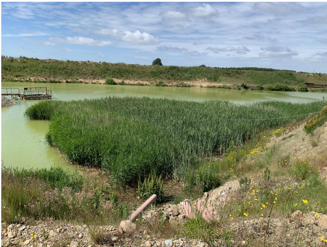
Figur 4.13: Sedimentationsbassin. Foto: NIRAS, 21. juni 2022.
