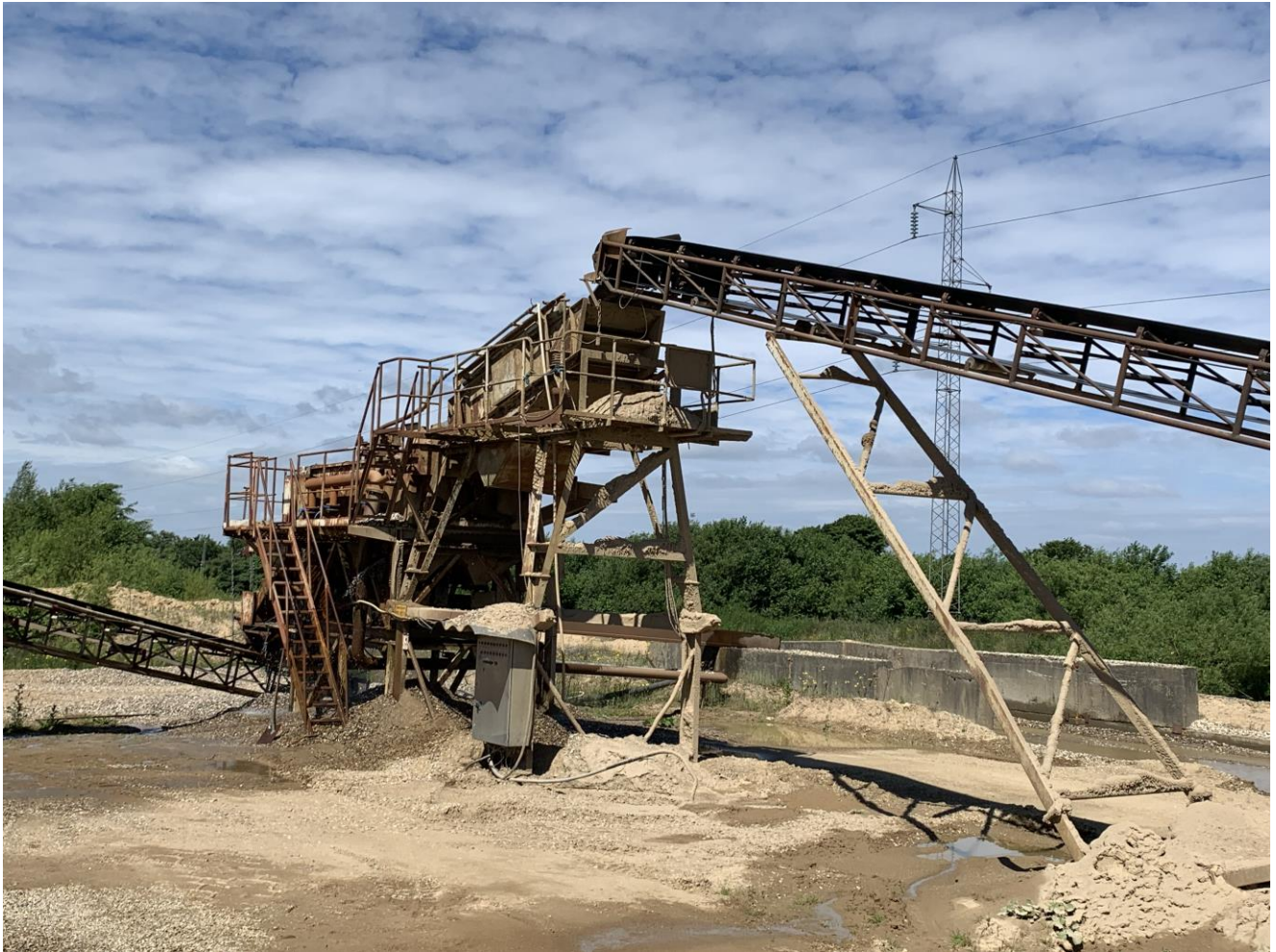
Figur 14.2: Østlige elmast mellem jigg og støjvold på matr. nr. 3a Asklev By, Them. Foto: NIRAS, 21. juni 2022.
