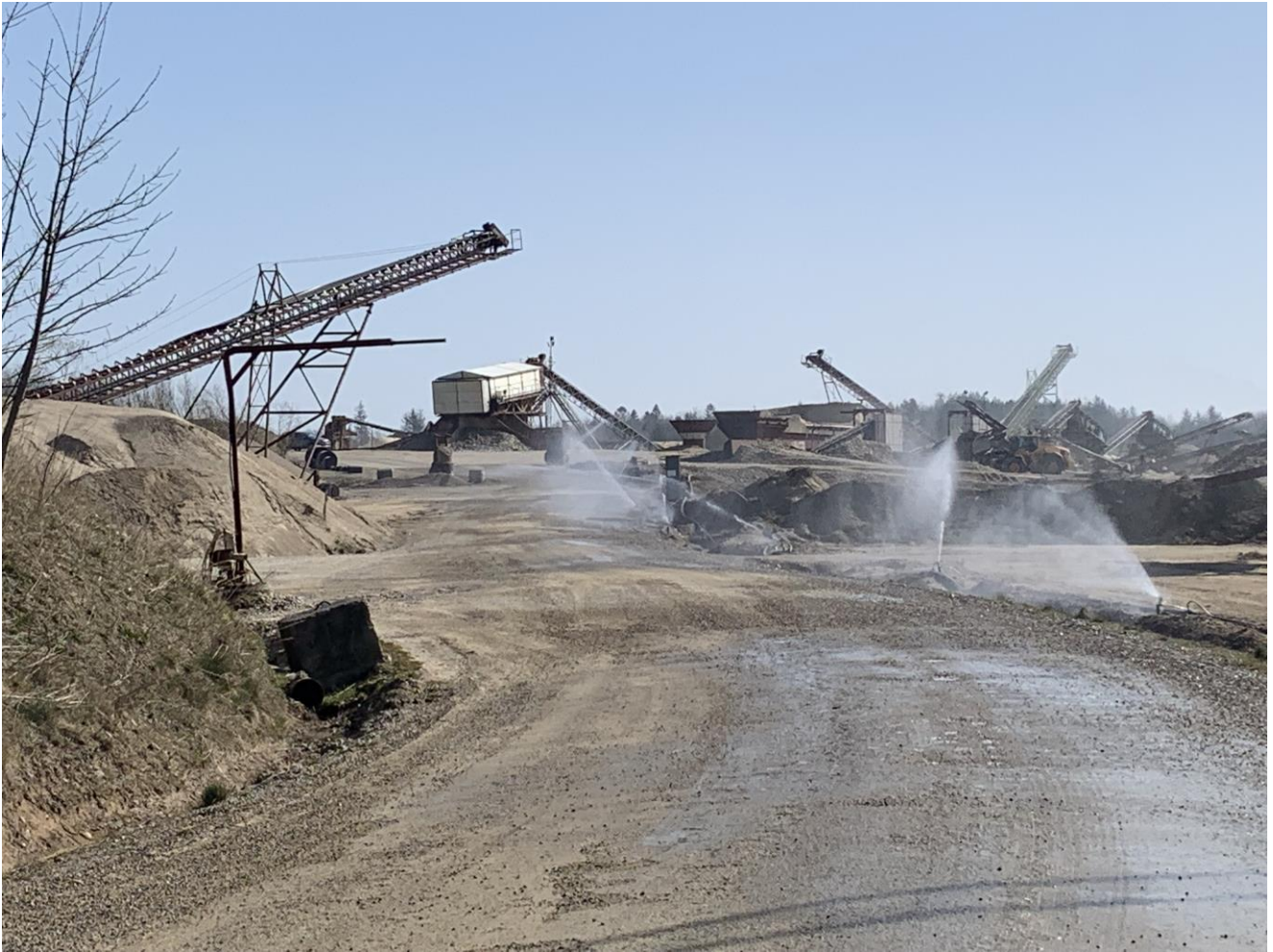
Figur 10.1: Vanding af adgangsvej med sprinkleranlæg. Foto: NIRAS, 9. maj 2022.
