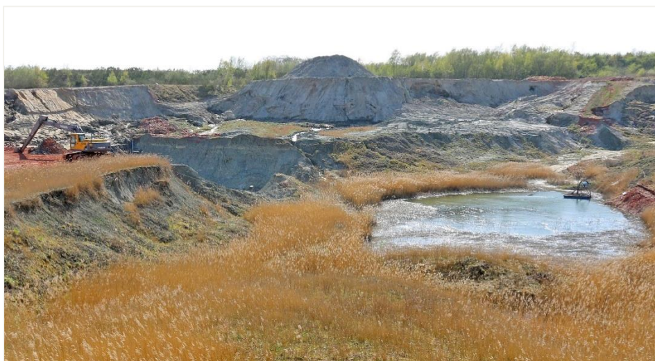
Figur 1.2: Sedimentationsbassin (vandhul) i den eksisterende grusgrav. Længst væk ses den flydende dykpumpe der leder vandet til Koholm Å. Foto: 23- 04-2019 Dansk Bioconsult Aps.
