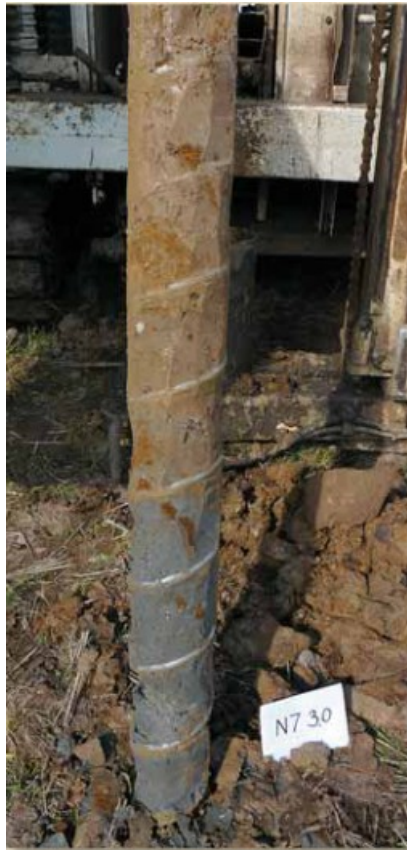
Figur 29: Boring der viser overgangen fra oxiderede til reducerede sedimenter. [7]
